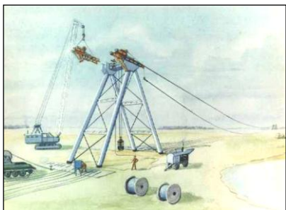
Рис. 11. Натяжение струны на анкерную опору
