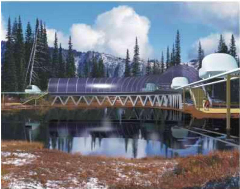
Рис. 11. Станция, совмещенная с поворотом трассы и анкерной опорой СТЮ
