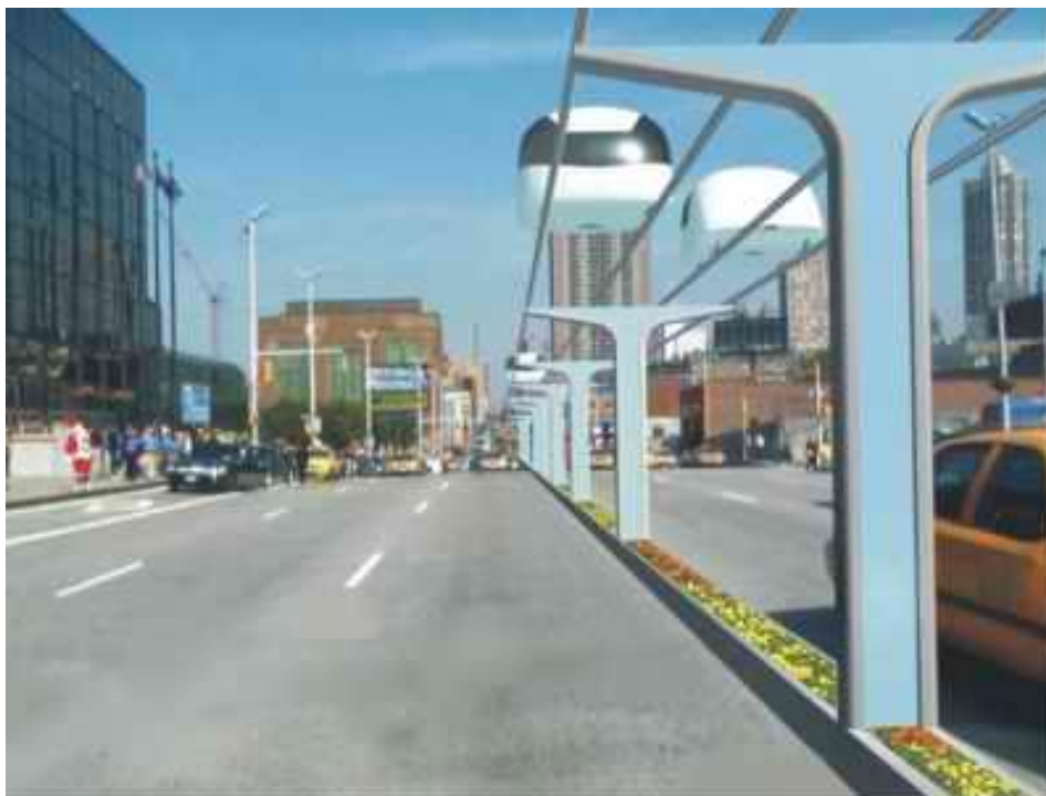
Рис. 1. Двухпутная трасса СТЮ на общих опорах скорость до 100 км/час
