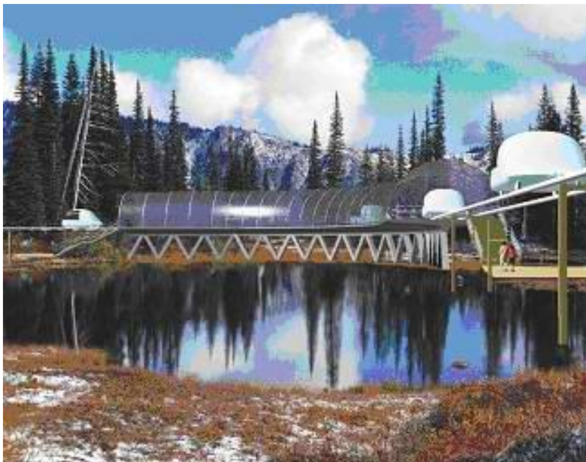
Рис. 3. Станция, совмещенная с анкерной опорой и углом поворота трассы СТЮ
